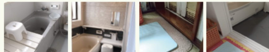
手すり工事前
